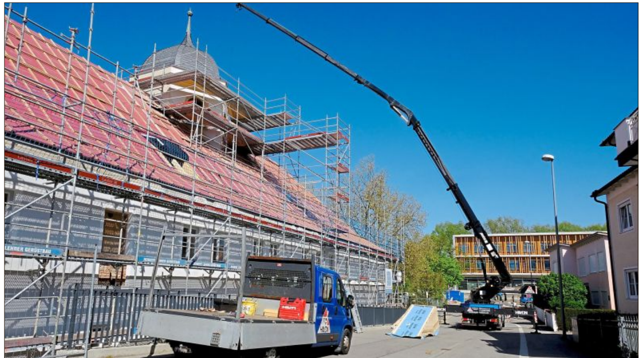
Das ehemalige Jugendzentrum an der Petersgasse. Kurz vor seiner Fertigstellung im Oktober 2017 brannte dieses Gebäude komplett aus. Derzeit werden die Dachgauben errichtet.
