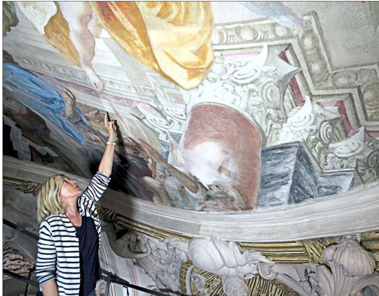
Die Arbeitsergebnisse am Chorgemälde zeigt Martina Oeter. Sie deutet auf die Grenze der Musterfläche zum noch nicht gereinigten Fresco-Teil. – Fotos: Staatl. Bauamt Passau
