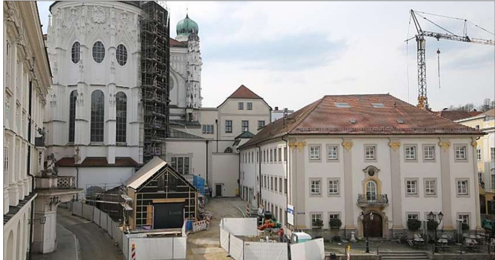
Zwischen mächtigen Nachbarn duckt sich die Dombauhütte regelrecht ins Eck: links die Neue Residenz, dahinter der Dom und rechts das Marshall-Haus. Damit der Neubau von unten möglichst niedrig wirkt, wendeten arc-Architekten aus Bad Birnbach einen optischen Trick an, denn das Dach fällt nach vorne ab. – Fotos: Staatl. Bauamt/Danninger
