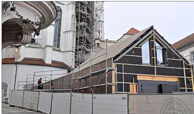
Die Giebelseite zum Residenzplatz ist noch nicht verschalt, an der Längsseite zur Zengergasse hin ist die Hülle an Dach und Wand fertig.
