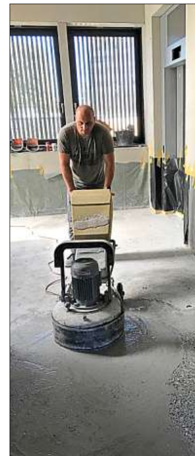
In den Treppenhäusern werden wie hier gerade die Terrazzofußböden sichtbar.
