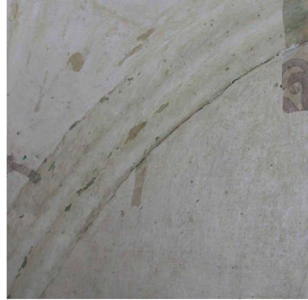
Abb. 94: Detail der östlichen Turmwand im Vorzustand
