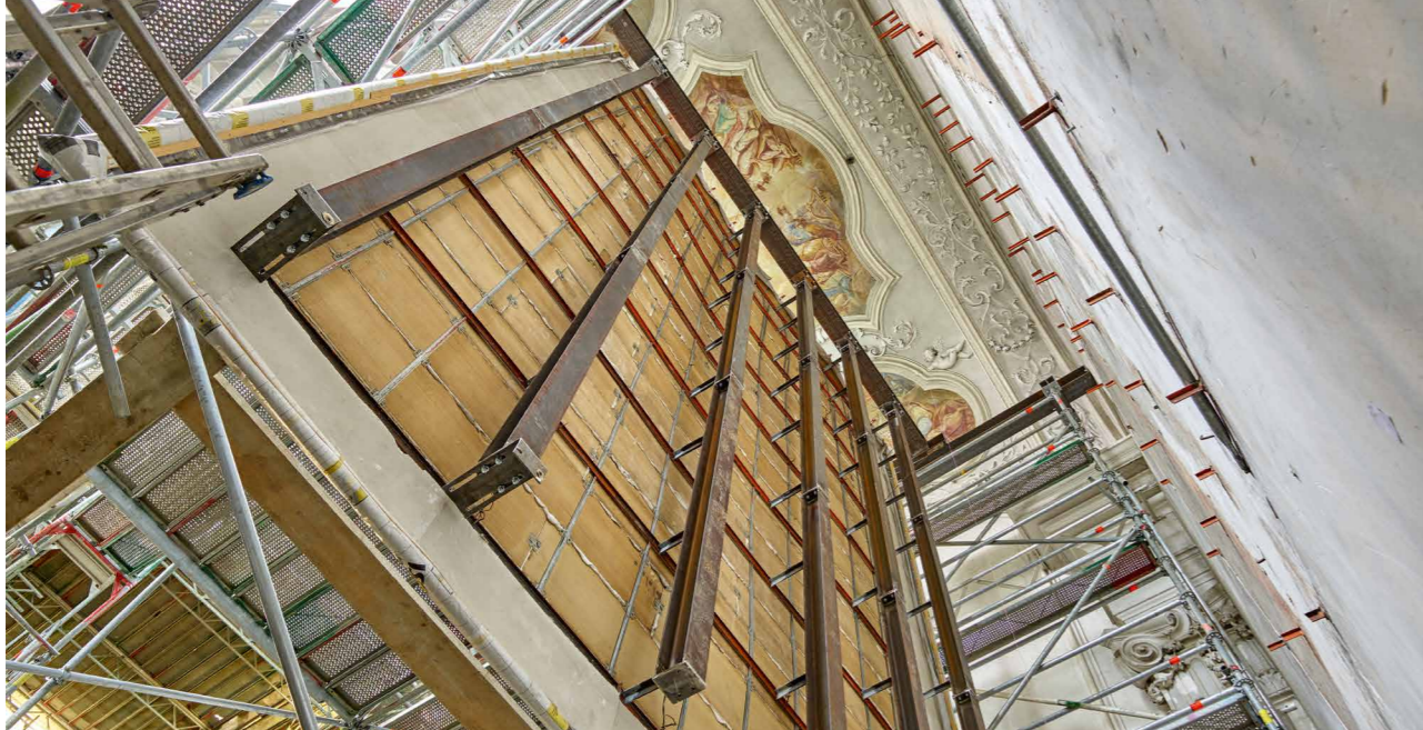
Abb. 9: Das bisher an der Chor-Ostwand auf Mauerwerk befestigte Monumentalgemälde von Erich Horndasch erhielt auf der Rückseite eine Tragkonstruktion aus Stahl, die mit Hilfe eines Schwerlastgerüsts nach vorne gerückt wurde. Das Gemälde steht heute als Altartafel in der ersten Gurtbogenachse des Chorraumes.
