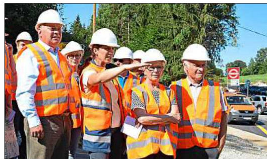
Susanne Hopfner (Mitte) und Amtsleiter Rober Wufka (r.) erklärten gestern unter anderem (vo. v.l.) Minister a.D. Helmut Brunner und Landrätin Rita Röhrl den Baufortschritt an der B 11 bei Gotteszell.
