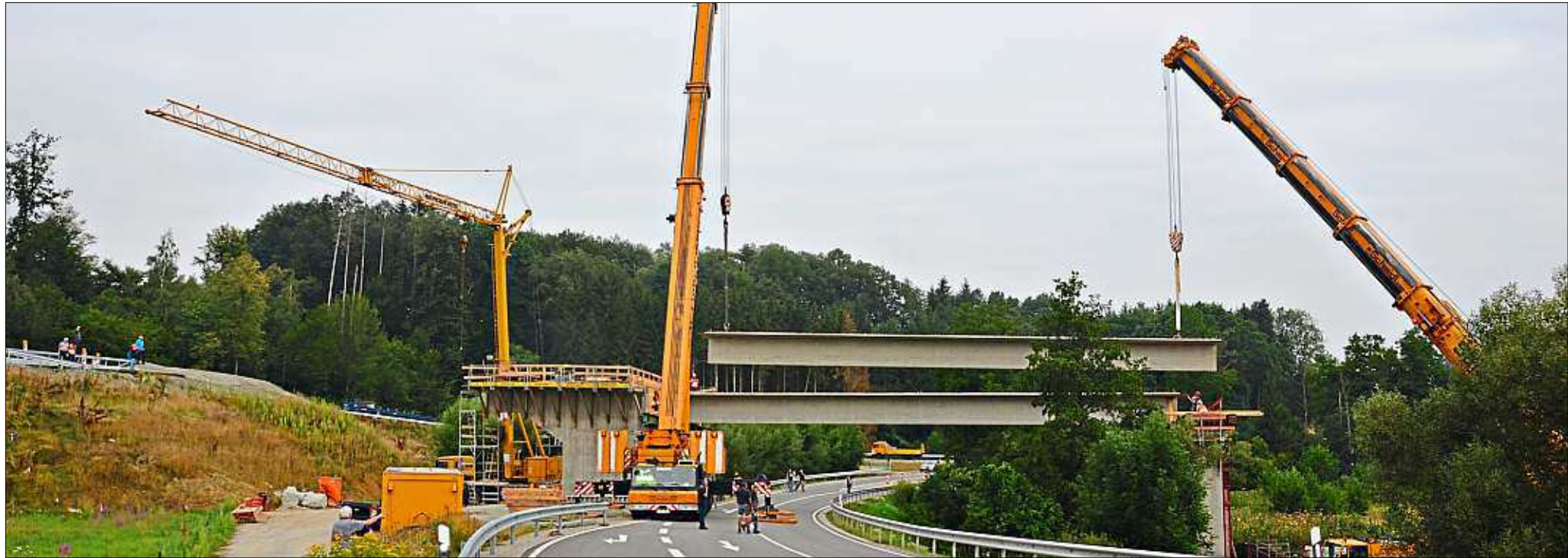
Am Dienstagmorgen ab 7 Uhr begannen die Arbeiten, gegen Mittag waren die ersten vier Plattenbalken von den beiden Autokränen in das erste Brückenfeld eingehoben worden. Die Arbeit wirkte sehr koordiniert und ruhig. – Foto: Rucker
