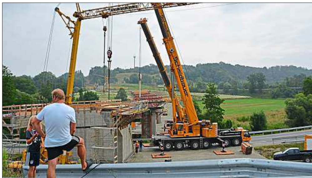
Bis zu 50 Personen verfolgten das Spektakel gestern Vormittag an der Baustelle. Bis Donnerstag sollen die Arbeiten abgeschlossen sein.
