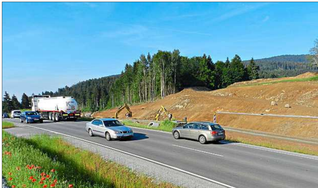
Aktuell fließt der Verkehr auf der Bundesstraße 11 bei Hochbühl über eine eigens errichtete Behelfsfahrbahn. Im Hintergrund sind die Reste des ehemaligen Waldstücks zu erkennen, das ebenso wie rund 6500 Lkw-Fuhren Erdreich abgetragen wurde. Die neue Fahrbahn der B 11 wird um vier Meter tiefer liegen. – Foto: Klotzek
