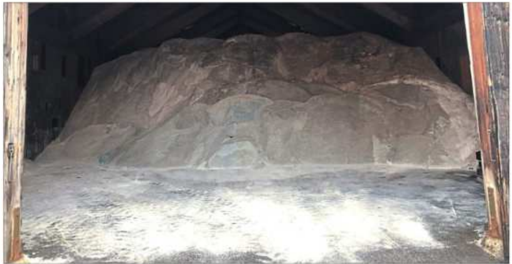
Mit 1400 Tonnen Streugut gefüllt ist das Salzlager auf dem Betriebsgelände der Autobahnmeisterei in Kirchroth. Zusätzlich halten Tanks 200 000 Liter Sole vor.
