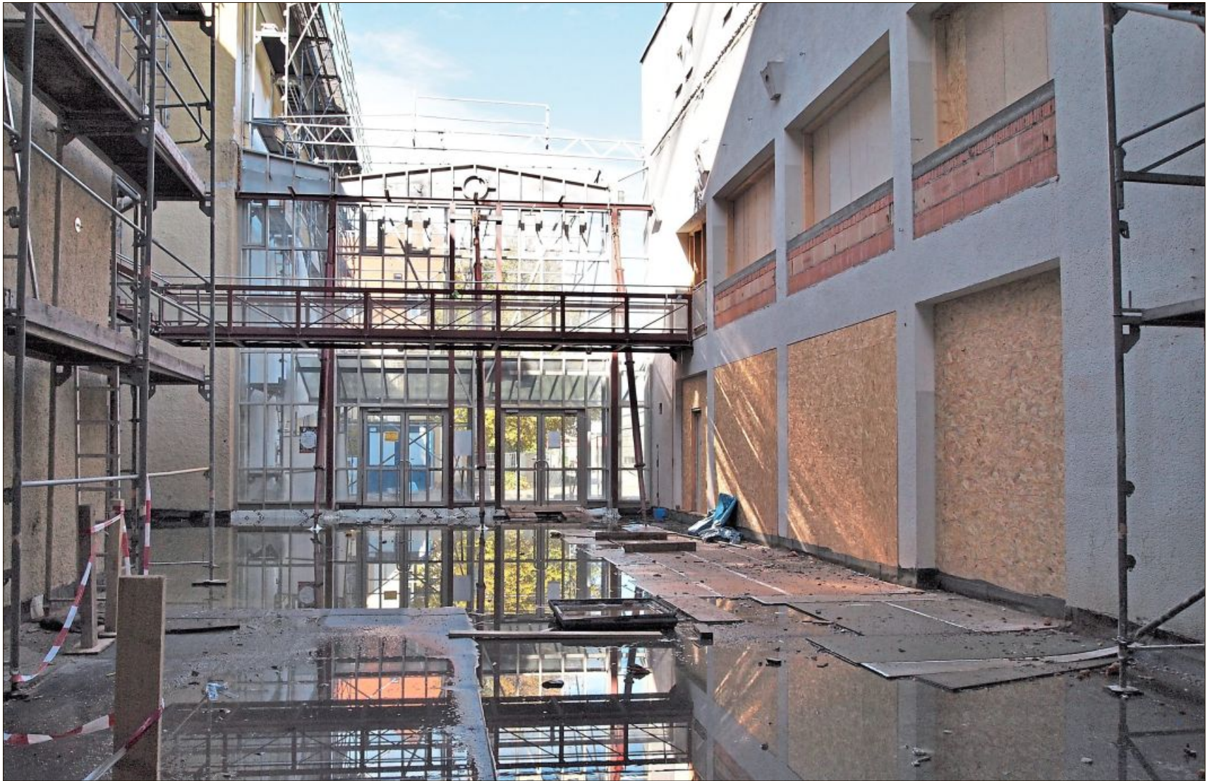
Sieht nach einem „Lost Place“ aus, ist aber die Aula des Comenius-Altbaus. Die Stahlträger für das Dach befinden sich derzeit in der Werkstatt.
