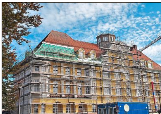
Der historische Altbau versteckt sich hinter Baugerüsten.
