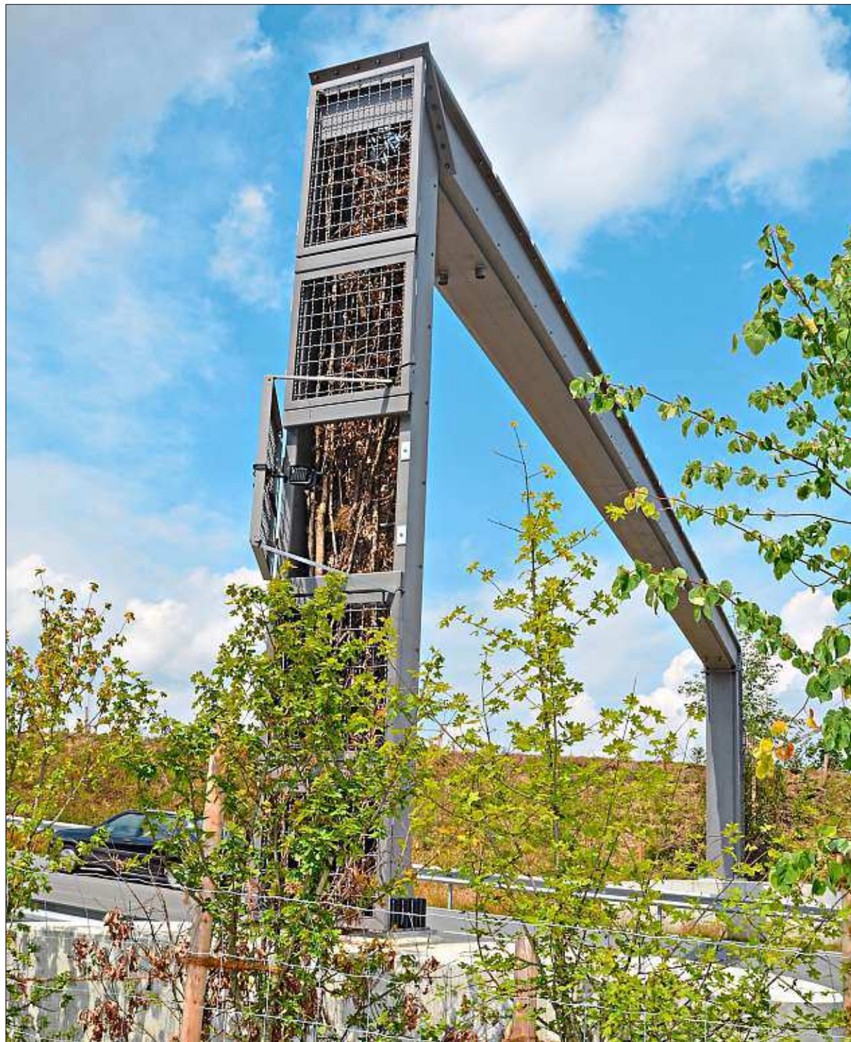
Diese sieben Meter hohe und 20 Meter lange Stahlkonstruktion soll den Haselmäusen dienen, die links und rechts der neuen Umgehungsstraße in Vilshofen ihren Lebensraum haben. Der Hohlkörper ist mit Ästen und Laub gefüllt. Eine Wildkamera wurde montiert, daher weiß man: Noch hat sie keine Haselmaus genutzt. – F.: Rucker
