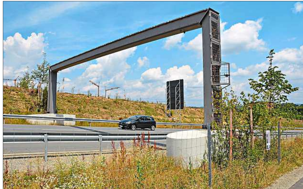
Die 93 000 Euro teure Querungshilfe für Haselmäuse kam ins Schwarzbuch des Bundes der Steuerzahler Bayern. Das Staatliche Bauamt macht klar: „Ohne Haselmausquerung gäbe es keine Ortsumgehung.“ – F.: Rücker
