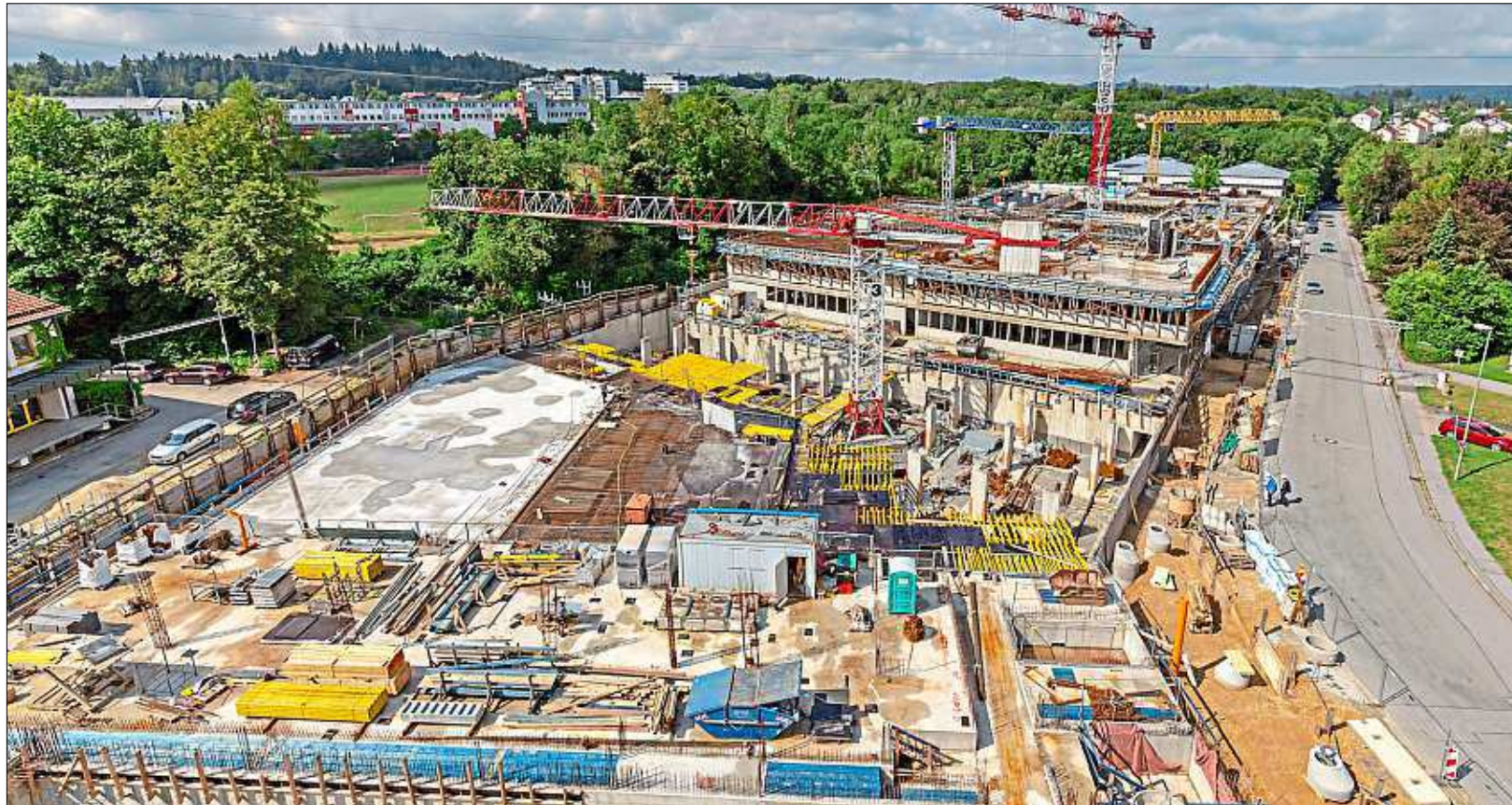
Ein Blick über die Baustelle nach Westen zeigt im Vordergrund das fertige Untergeschoss des Parkdeck- und Kantinegebüdes, dann den Tiefgaragen-Verbindungsbau (Schararbeiten) und dahinter das künftige Hauptgebüde des Neubaukomplexes. – Foto: Kinateder/StBA Passau
