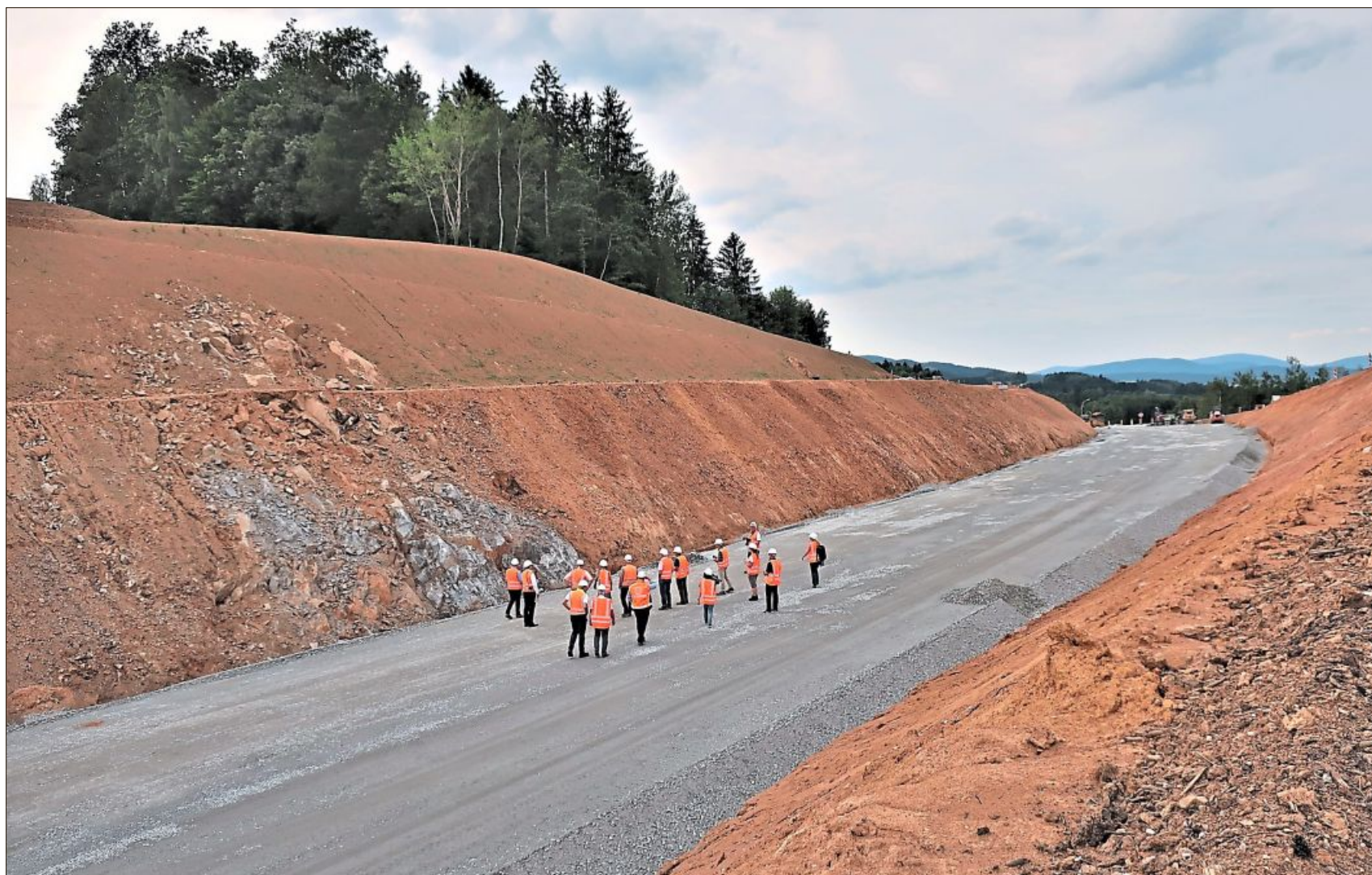
Deutlich erkennbar: die neue Trassenführung der B11 bei Hochbühl. Die Bürgermeister machten sich am Montag ein Bild von der Lage.
