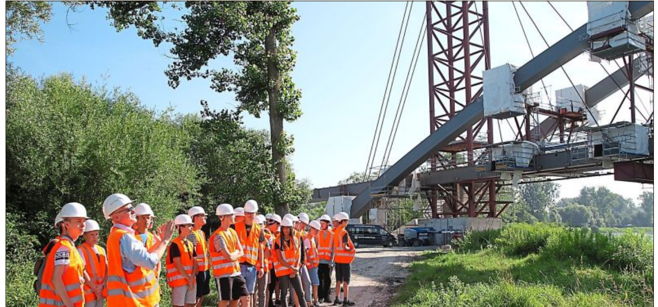
Bauen macht Schule: Walter Hinkofer (l.) von der Servicestelle Deggendorf des Staatlichen Bauamts Passau gab den Schülern einen Einblick in den Brückenbau.
