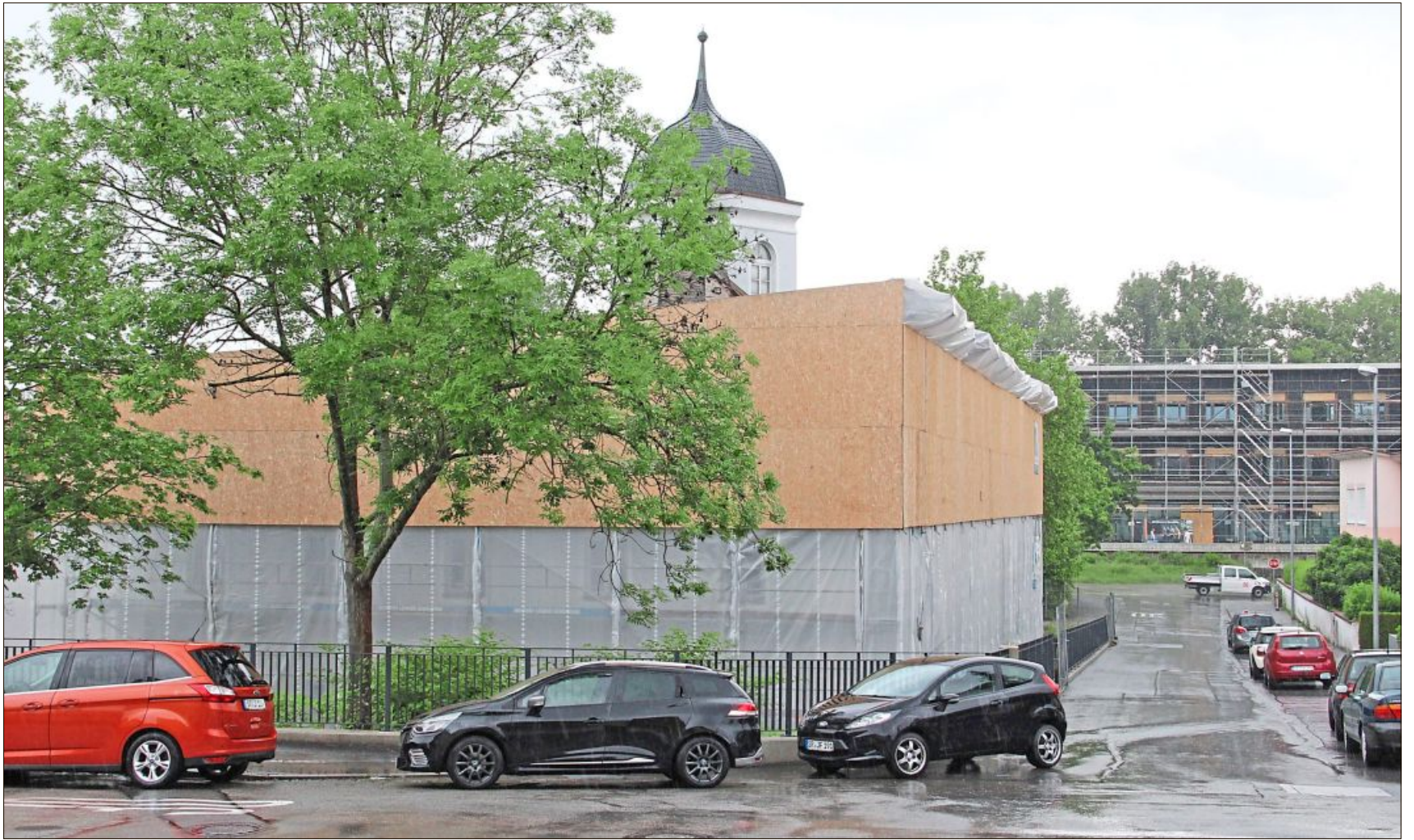
Das ehemalige Jugendzentrum an der Petersgasse: Der Dachstuhl des aufwendig sanierten Gebäudes brannte im Oktober 2017 kurz vor der Inbetriebnahme als Lehrstuhl- und Verwaltungsgebäude des TUM-Campus ab. Der Wiederaufbau beginnt nach Angaben des Staatlichen Bauamts Passau in der zweiten Junihälfte.
