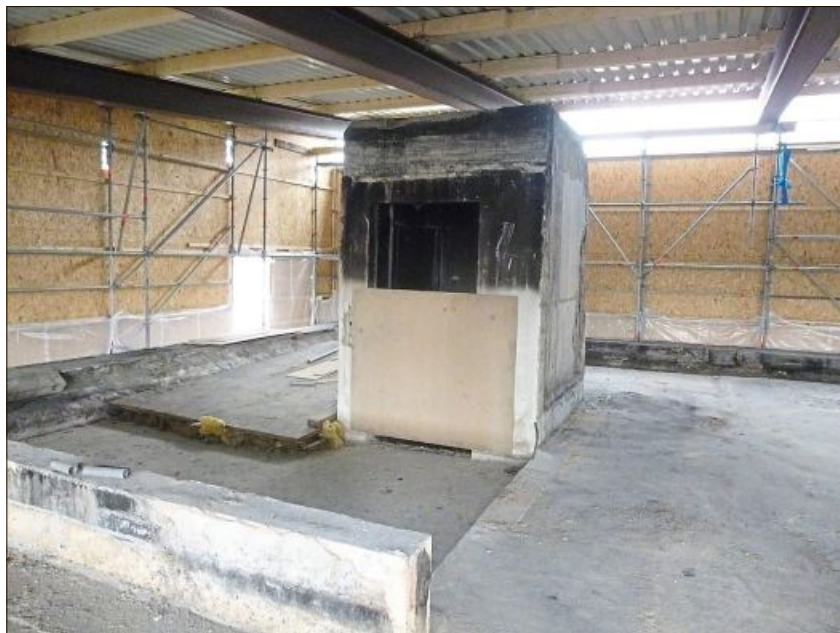
Blick in den Dachstuhl: Der Schachtkopf des Aufzugs (Mitte) muss wegen der Brandschäden neu gebaut werden. Foto: Staatliches Bauamt Passau
