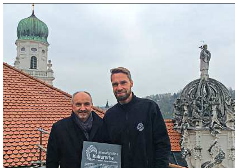
Eine Leistung, auf die man stolz sein kann: Der Leiter der Passauer Dombauhütte, Jérôme Zahn (rechts), und Norbert Sterl, Leitender Baudirektor am Staatlichen Bauamt Passau, präsentieren auf dem Dach des Doms vor dem Stephanstürmchen (r.) die Auszeichnung der Unesco als Immaterielles Kulturerbe. Mittlerweile zielt das Schild den Eingang zum Büro der Dombauhütte am Marshallhaus auf dem Residenzplatz.
