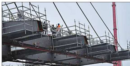
Die Stahlbauer auf der Brücke arbeiten trotz eisiger Temperaturen in schwindelerregender Höhe.
