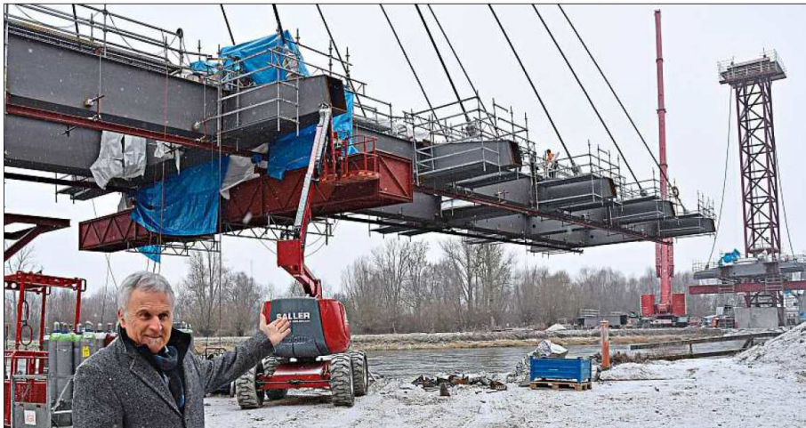
Freut sich über den derzeitigen Baufortschritt: Robert Wufka, Leiter des staatlichen Bauamts Passau. Stück für Stück wächst die Brücke über der Isar zusammen: Derzeit wird der Stahlrost, auf dem später die Fahrbahn verläuft, eingesetzt. – Fotos: Woipich
