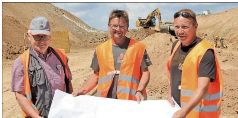
Gearbeitet wird von 6 Uhr morgens bis 18 Uhr abends. Bauaufseher Lothar Deuschl (r.), Polier Thomas Metzger (Mitte) und Max Drexler, verantwortlicher Bauleiter für die Ingenieurbauwerke der Maßnahme, sind mit dem Fortschritt sehr zufrieden.
