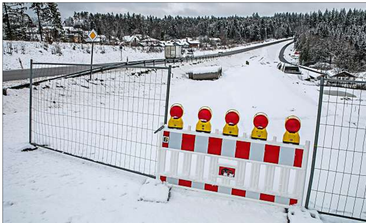
Schwerpunktthema B 12: Der dreistreifige Ausbau bei Salzweg wird heuer fortgesetzt, auf knapp zwei Kilometern Länge wird ein dritter Fahrstreifen gebaut. – Foto: Jäger
