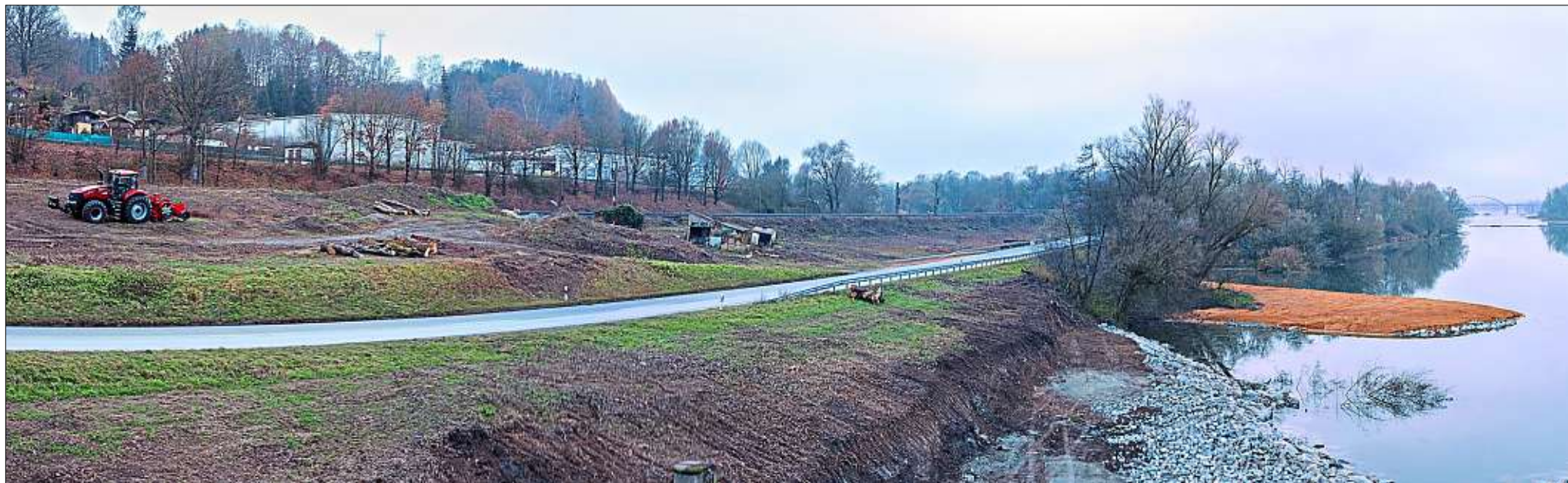
Die Umfahrung von Vilshofen ist ein Millionen-Projekt und zählt auch 2019 zu den größten Baustellen des Staatlichen Bauamts im Landkreis Passau. Ab April soll es an der B8 zwischen Witzling und Wolfachmündung mit dem Bau des Kreisverkehrs losgehen. – Foto: Laudi
