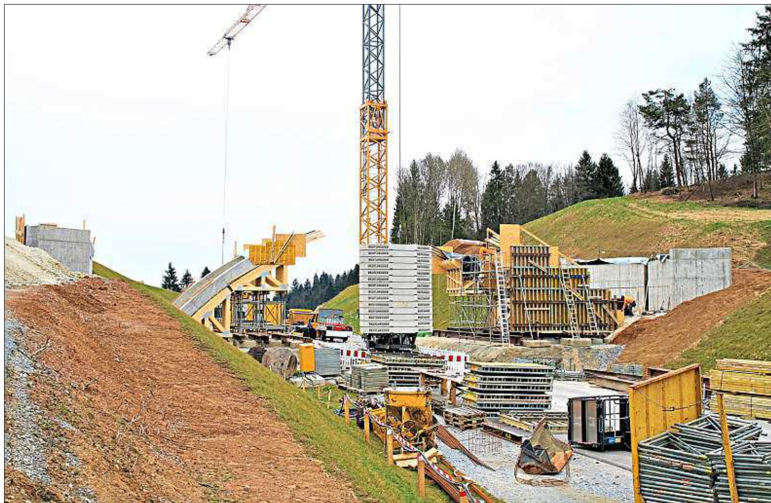
Vor dem Stopp der Arbeiten wegen der Corona-Krise wurden noch die vier Pfeiler für den Überbau der neuen Bogenbrücke am Hochbühl betoniert. – Foto: Süß/Staatliches Bauamt Passau
