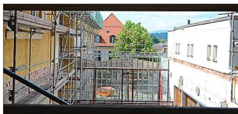
Der Pausenhof zwischen Alt- und Neubau wartet auf sein neues Dach.
