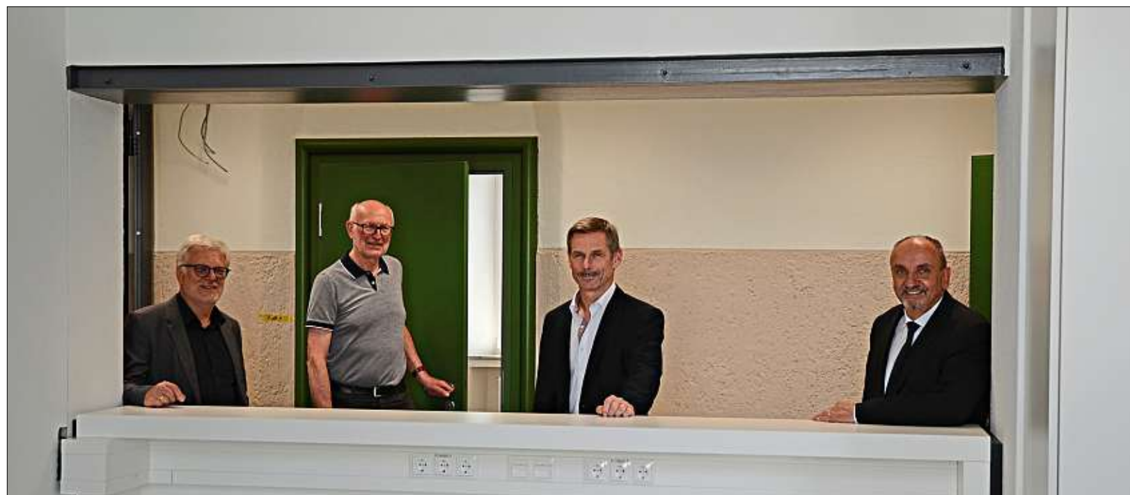
Wo früher eine durchgehende Mauer war, öffnet sich nun das Sekretariat zum Gang hin. Karl-Heinz Gollwitzer öffnet die Tür, durch die man das Direktorat betreten kann. Zusammen mit Felix Viemann (v.l.), Stefan Kayser und Norbert Sterl präsentiert er die Baustelle. – Fotos: Schreiber
