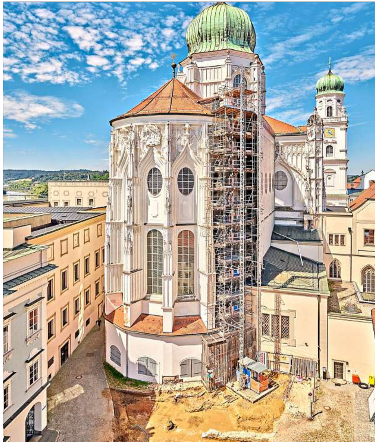
Ein Blick auf die Baustelle am Dom: Für die neue Dombauhütte musste etwas in die Tiefe gegraben werden. Dabei stießen die Archäologen auf Überraschungen. – Foto: Marcel Peda
