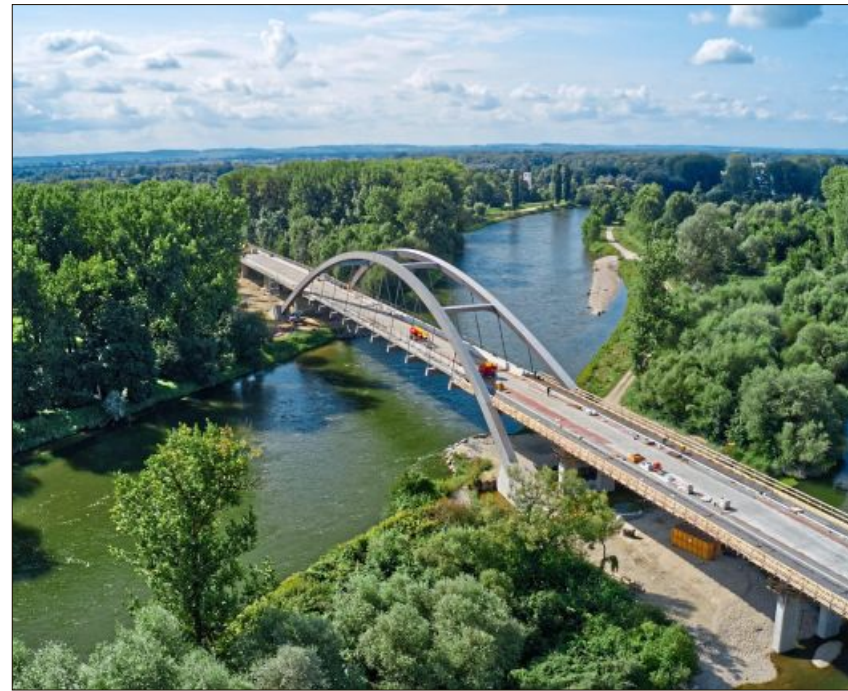
Bei der neuen Nepomukbrücke steht der Farbanstrich noch aus.
