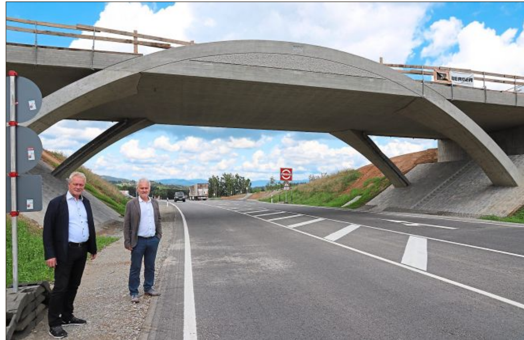
Vor der neuen Bogenbrücke am Hochbühl tauschten sich Leitender Baudirektor Robert Wufka (r.) und CSU-Bundestagsabgeordneter Alois Rainer über den Fortschritt der Arbeiten zum Ausbau der Bundesstraße 11 aus.
