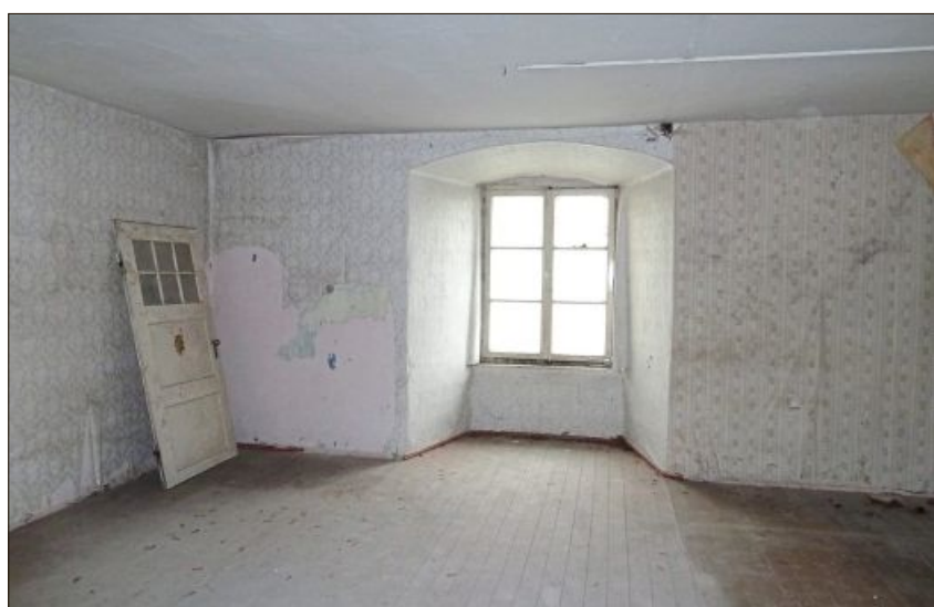
Die Räume brauchen eine grundlegende Sanierung: Zuletzt waren sie in der Nachkriegszeit bewohnt.
