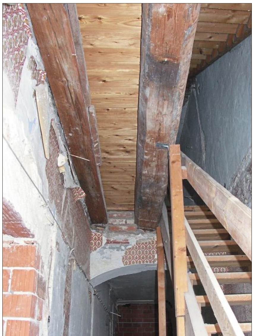
Die provisorische Treppe im Westturm wird sicherlich weichen. Wie man die vier Geschosse verbindet, steht noch nicht fest.
