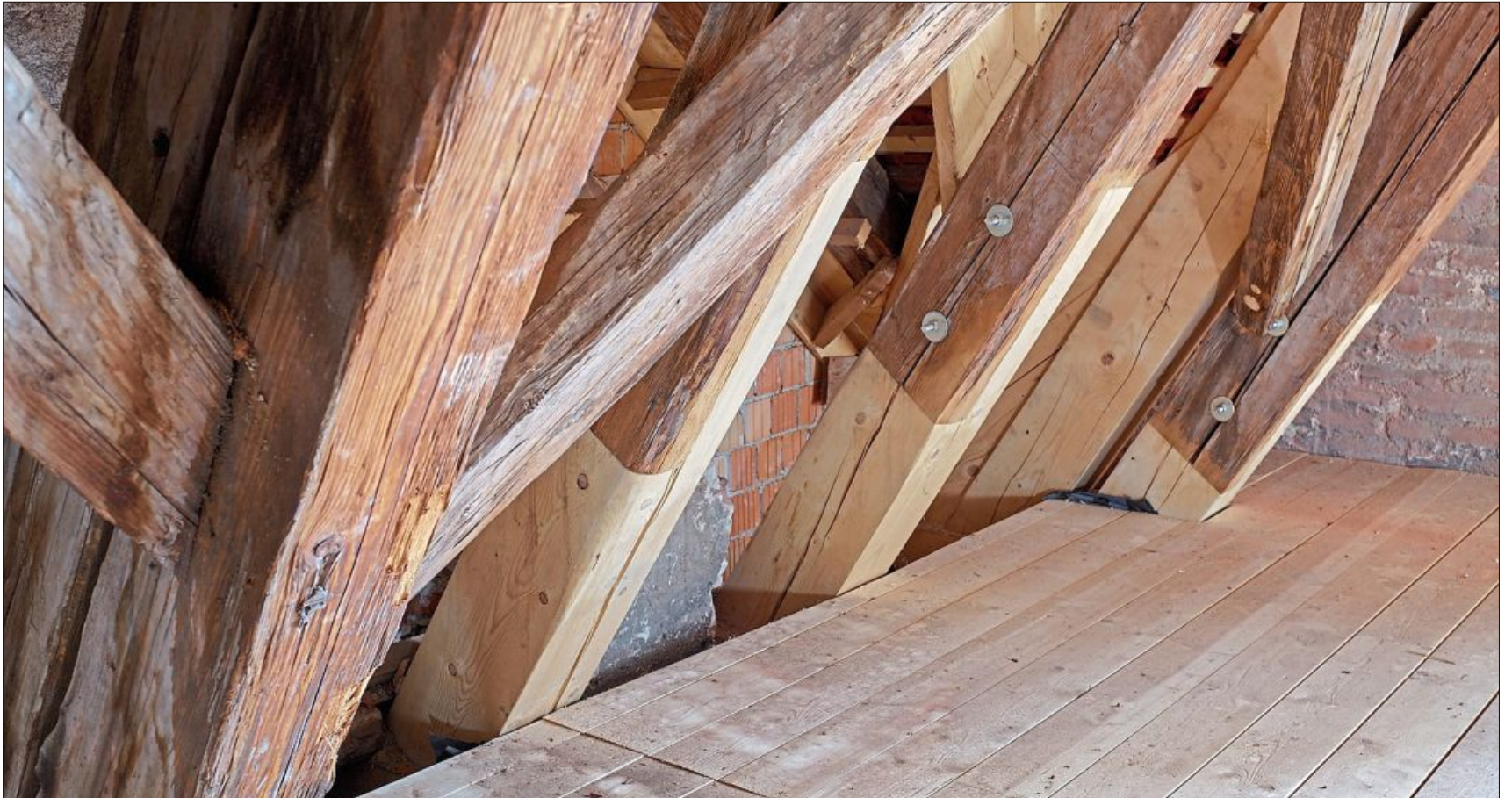
Der Dachstuhl im Westturm wurde bereits saniert, die Dachdeckung erneuert. Nun geht es an die Innenräume.
