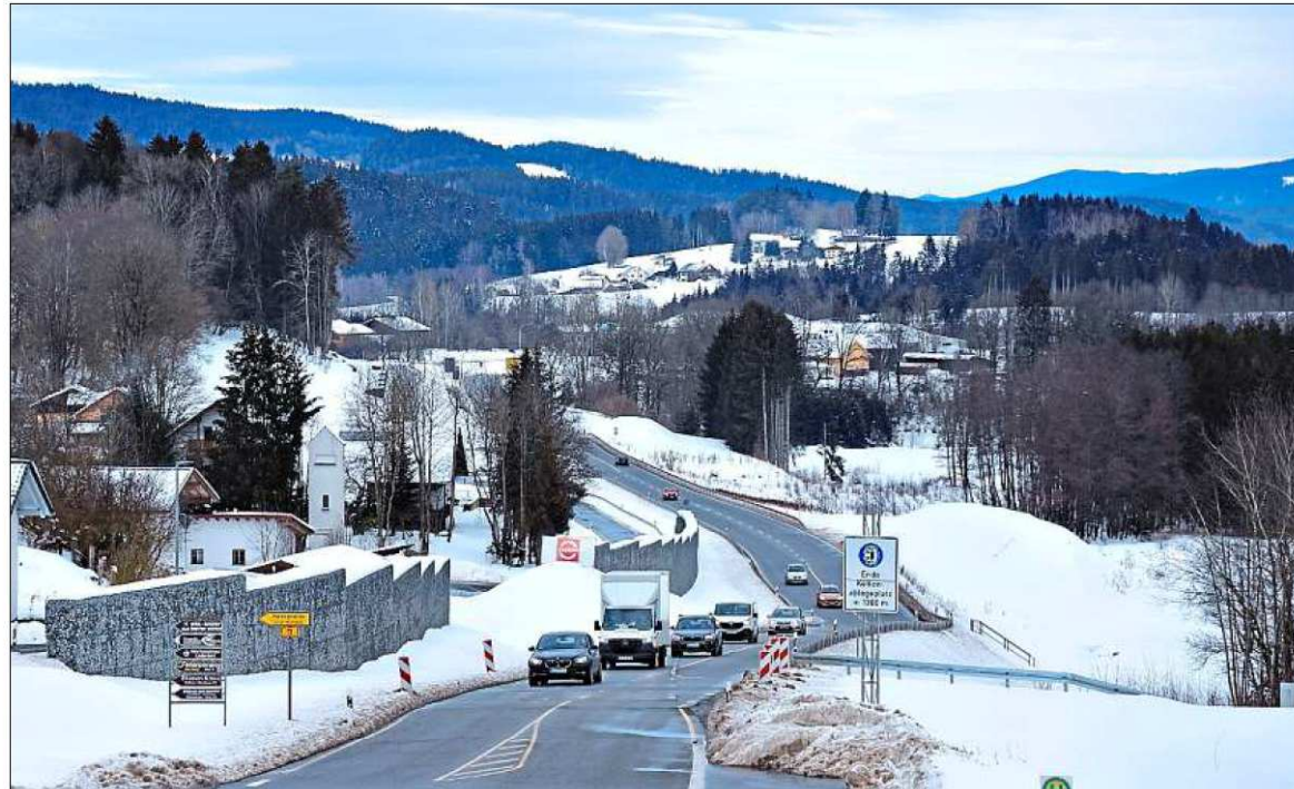
Baustelle auf der Bundesstraße 11 am Hochbühl: Im vergangenen Jahr wurden auf der B 11 zwischen Grafing und Gotteszell Gabionenwände und ein Regenrückhaltebecken errichtet, ebenso wurde die Fahrbahn verlegt. Fertiggestellt wurde die Bogenbrücke am Hochbühl. – Foto: St. Bauamt
