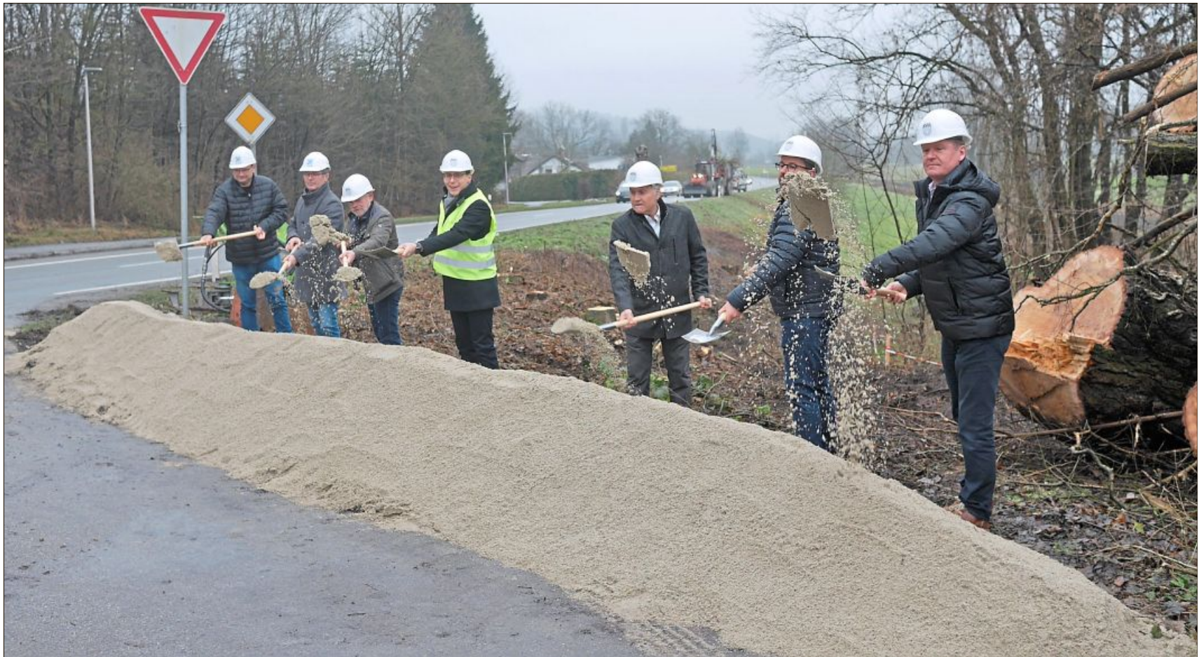
Am Freitag fand der Spatenstich für die neue Radweg-Unterführung in Seebach-Halbmeile statt.
