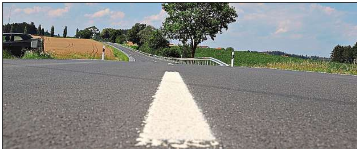
Die teuerste Maßnahme war die Sanierung der B 20 bei Zeilarn.
