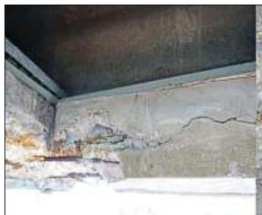
Risse, Betonabplatzungen und freiliegende Bewehrungsteile: Nahezu die gesamte Brücke ist von den Schäden betroffen.
