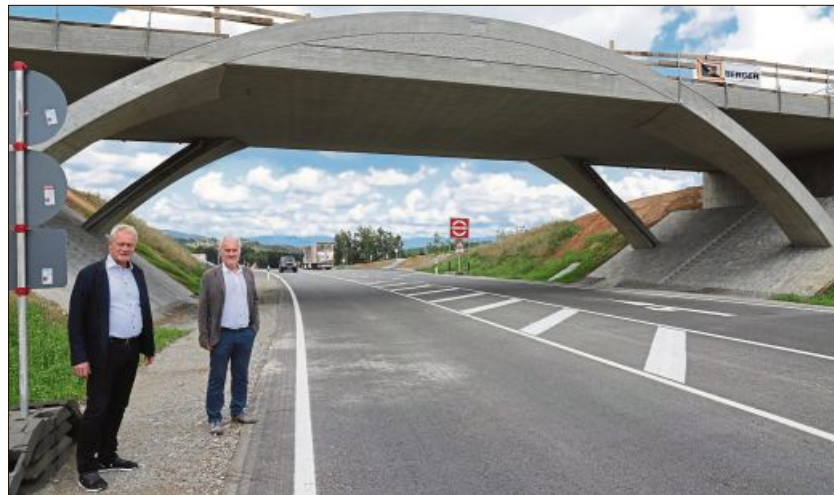
Eines der Hauptprojekte für Wufka (r.) war der Ausbau der B11, unter anderem mit der neuen Brücke bei Hochbühl. Foto: Archiv
