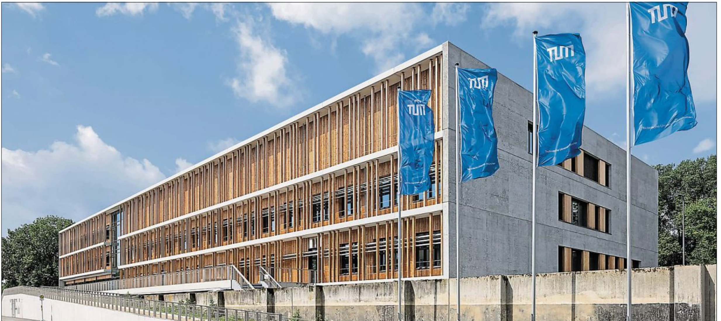
Ansicht des neuen Lehr- und Forschungsgebäudes von der Uferstraße aus: Treppen und Rampen erschließen die Eingangsebene auf der aufgeständerten Plattform über der Hochwasserschutzmauer.
