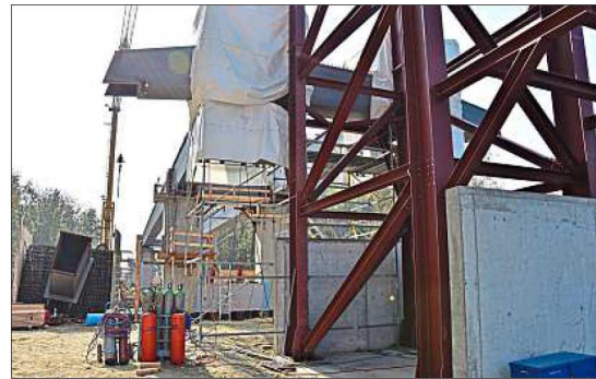
„Ein Meisterstück über die Isar“ wird die Brücke laut Baustaatssekretär Josef Zellmeier sein, wenn sie 2020 fertig ist. – Fotos: Schweighofer
