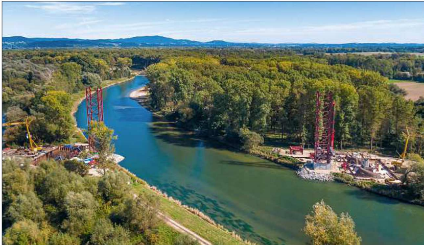
Die Baustelle aus der Luft: Gut zu sehen sind auf beiden Seiten der Isar die 41 Meter hohen roten Pylonen, die benötigt werden, um weitere Bestandteile der Brücke einheben zu können. – Foto: Staatliches Bauamt
