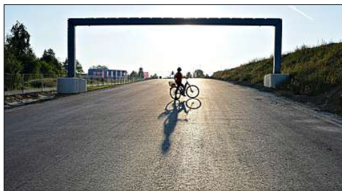
Die Haselmausbrücke von Vilshofen im Gegenlicht – noch vor der offiziellen Verkehrsfreigabe. – Foto: Seidl
