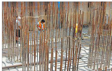
Einen „Knochenjob“ nennt Robert Wufka die Arbeit der Eisenflechter. Sie leisten wichtige Vorarbeit für das Kämpferfundament, auf dem am Ende das Gewicht der Brücke lastet.
