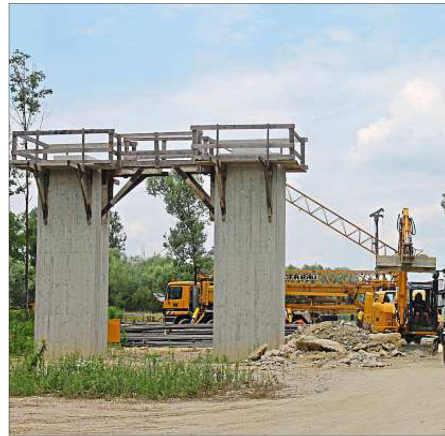
Ein Baggerfahrer und seine Kollegen verrichten Betonarbeiten auf Höhe der späteren Vorlandbrücke rechts der Isar.
