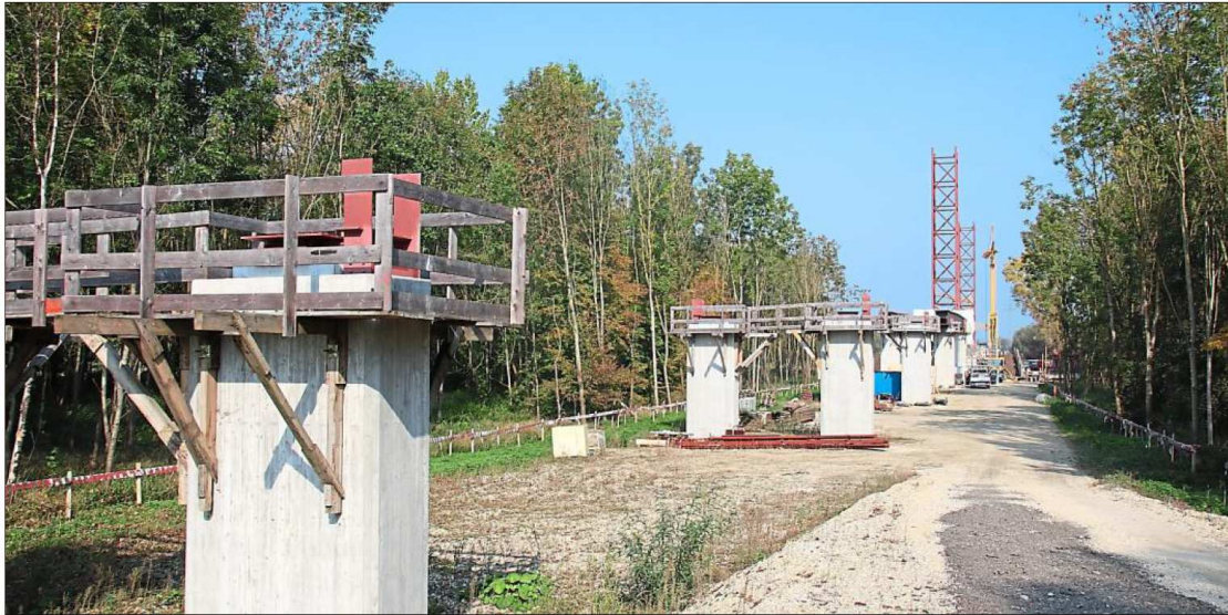
Beindruckende Baustelle mit viel Beton und Stahl.
