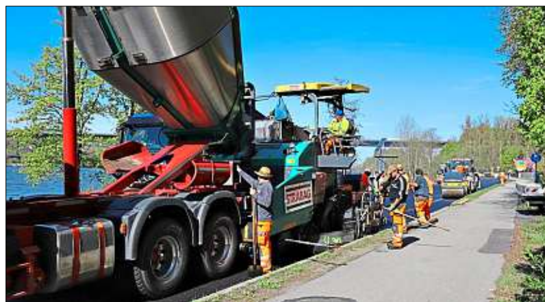
Die Fahrbahn der St 2125 bei Zieglstadt wurde erneuert, dabei wurde in einem Teilbereich lärmindernder Asphalt aufgebracht.
