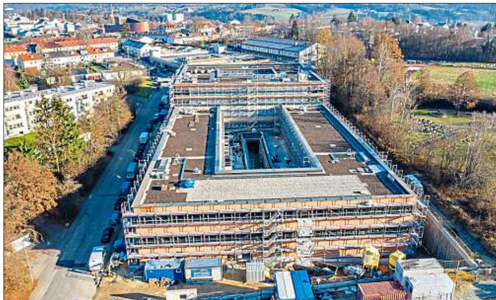
Der Neubau für die Landespolizei in Passau war im vergangenen Jahr die größte Hochbau-Baustelle des Staatlichen Bauamts Passau.
