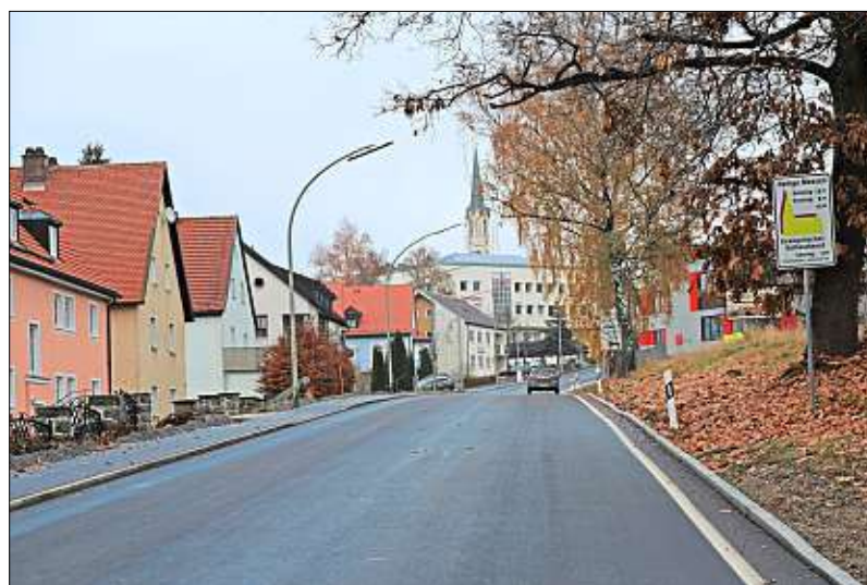
In monatelanger Arbeit wurden die Staatsstraßen in der Ortsdurchfahrt Freyung saniert – ein Beitrag zur Vorbereitung auf die Landesgartenschau.
