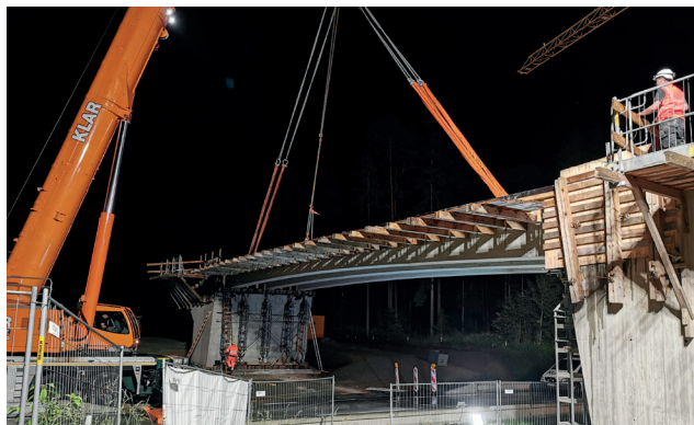
Einhub der Fertigteilträger an der Brücke bei Schern. Foto: Sabine Süß, Staatliches Bauamt Passau
