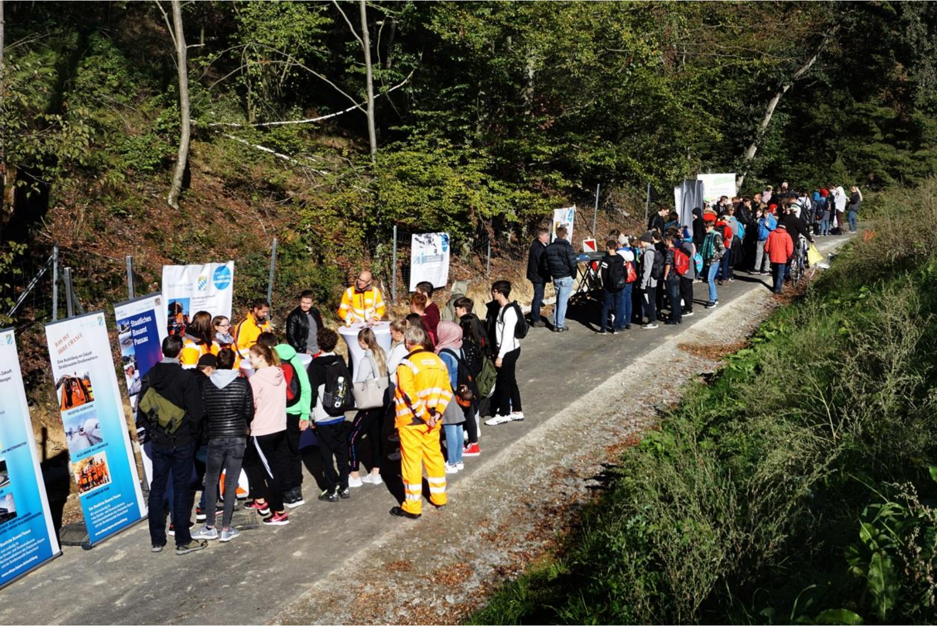
Infostände entlang der Baustelle der Ortsumgehung Vilshofen
